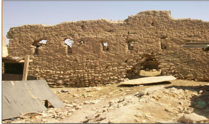
(الصورة - ٣) الجدار الجنوبي للديوان
